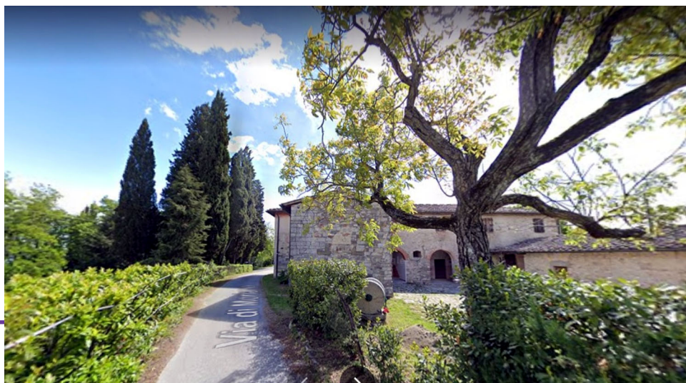
Il podere di Moriano, con l'edificio della antica chiesa, da Google maps (via di Moriano, 44).
